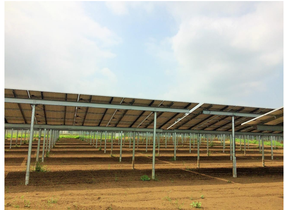
太陽光パネル設置状況
